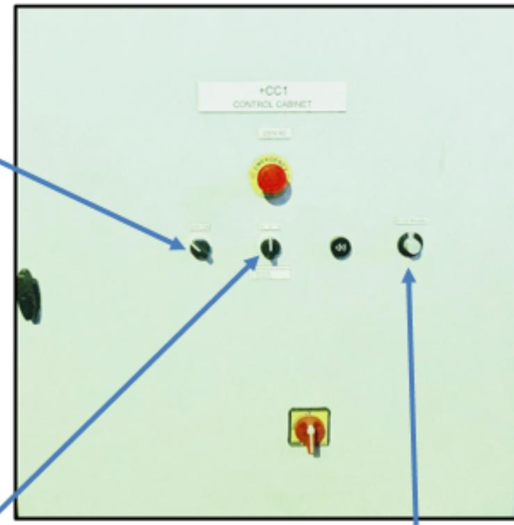
Med tidsbryteren velger du hvor lang tid maskinen skal gå.
